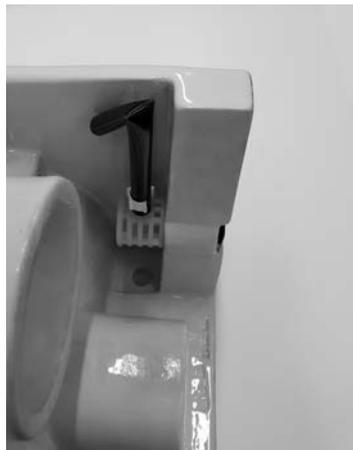
A fissaggio ultimato, se il tubetto sporge dalla ceramica ripiegare la parte in eccesso verso l'interno del sanitario.
